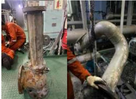
Gambar 10 Proses Pelepasan *Eductor Pump* Dari Pipa Instalasi *Ballast*
